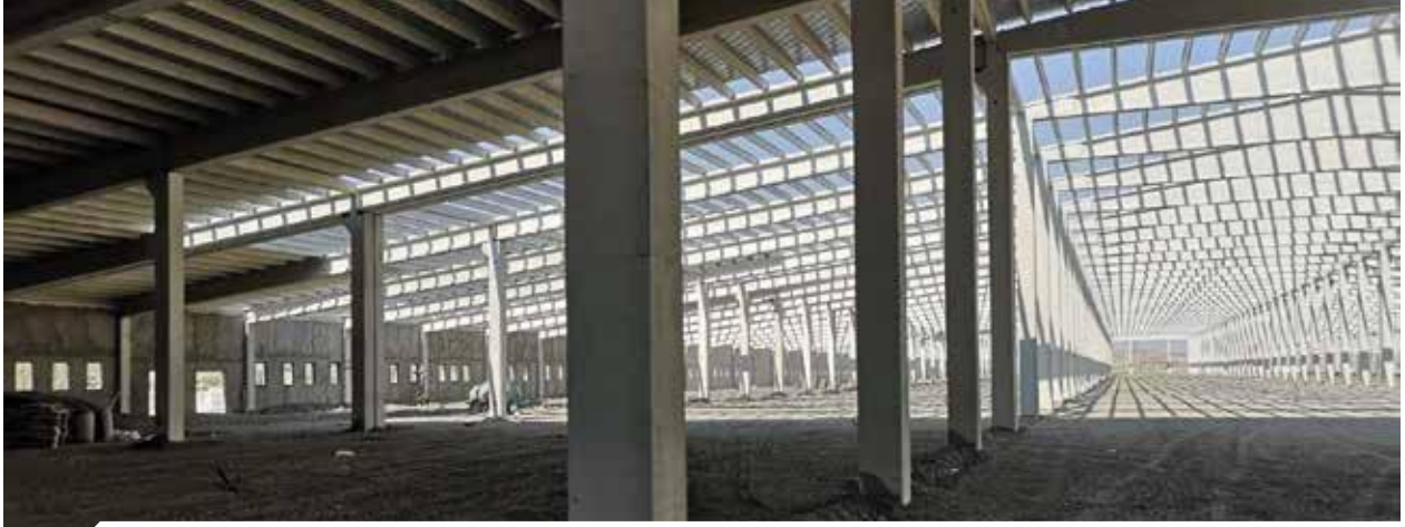
Ağrı Nike Fabrikası
